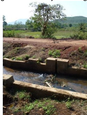
(d) Informal cross regulator and slotted offtake
